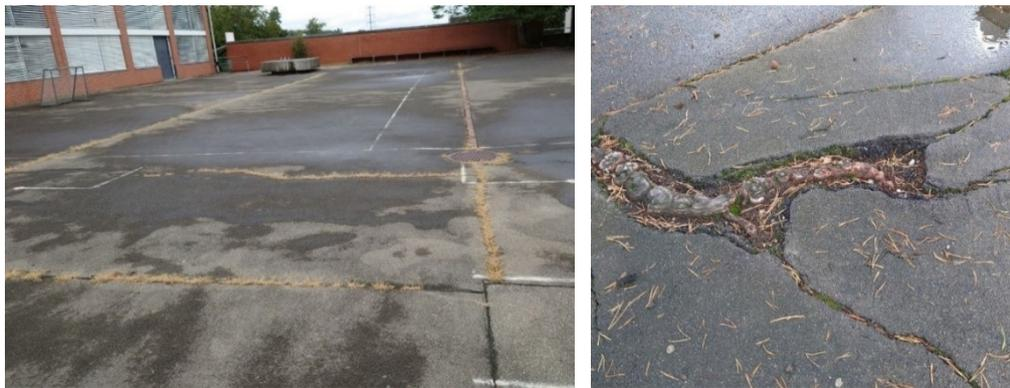
Auf dem Pausenplatz wachsen Gräser zwischen den Asphaltplatten und ausserdem reissen die Wurzeln des Baumes den Asphaltbelag auf.
