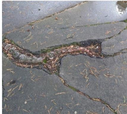
Auf dem Pausenplatz wachsen Gräser zwischen den Asphaltplatten und ausserdem reissen die Wurzeln des Baumes den Asphaltbelag auf.
