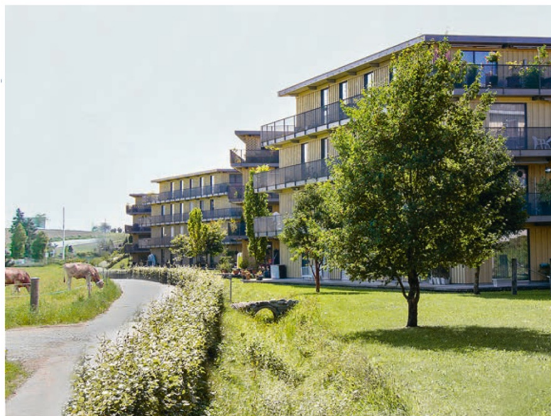
Die offene Bebauungsstruktur der Siedlung Wolfswinkel in Zürich Seebach verzahnt Siedlung und Landschaft (Hager Partner AG)
